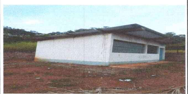
Foto 4: Sustrucción de lámina por lámina troquelada aluzinc calibre 26
