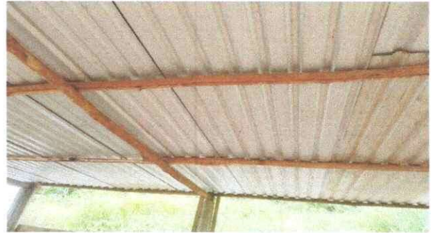
Foto 2: Sustrucción de estructura de soporte de madera, por metal de cocina
