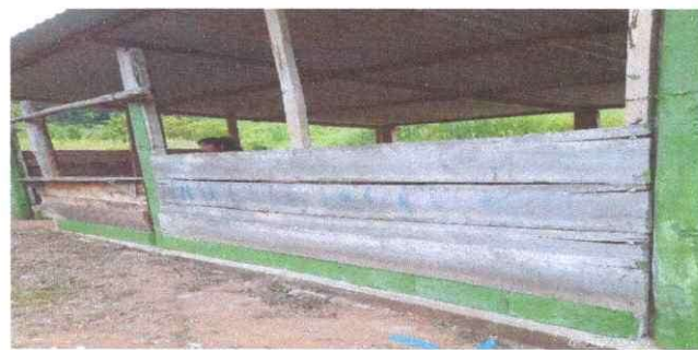
Foto 3: Sustrucción de puerta.
