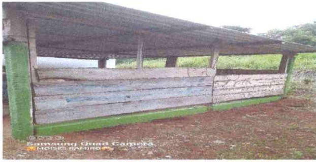
Foto 1: Sustrucción de lámina por lámina troquelada aluzinc calibre 26 de cocina
