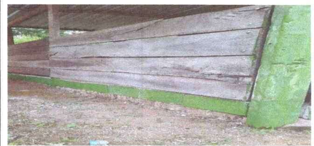
Foto 6: Sustrucción de piso de torta de concreto.
